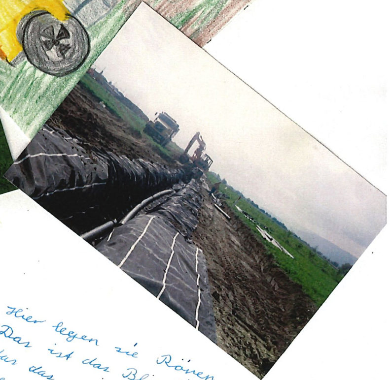
Hier sieht man die ganze Baustelle.
