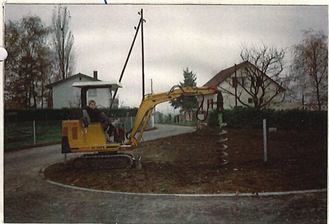
Dies ist ein Bohrbagger Das ist ein Bohrbacker
