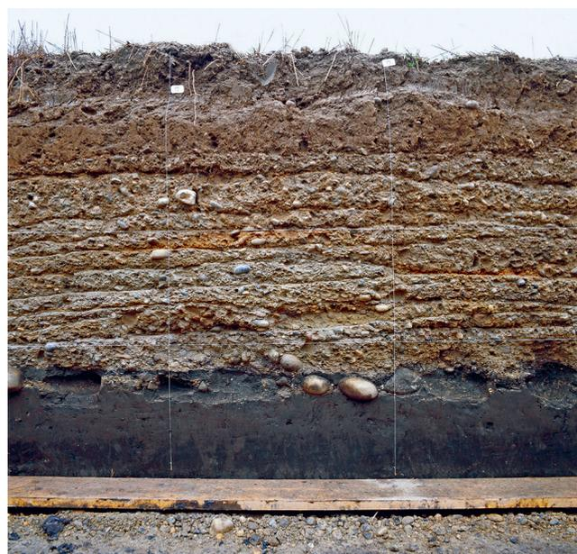
Abb. 2: Profil der römischen Strasse in Leuzigen mit mehreren, übereinanderliegenden Fahrbahnen.
